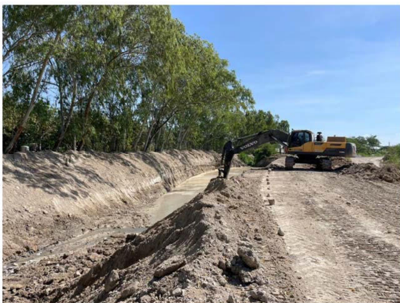
รูปที่ 8 การขุดร่องน้ำบริเวณขอบบ่อเหมืองตามแนวพื้นที่ประทานบัตรของโครงการ
